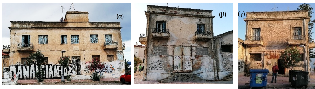
Εικόνα 2. α) Ανατολική, β) Βόρεια και γ) Νότια Όψη κτιρίου.
