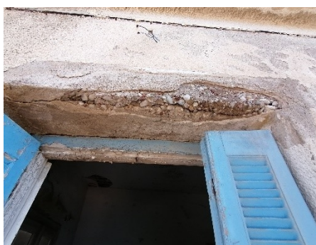
Εικόνα 7. Λεπτομέρεια πρεκιού, όπου φαίνεται το υλικό κατασκευής του.
