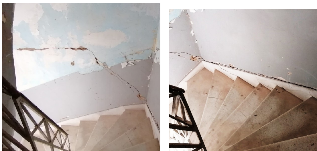
Εικόνα 11. Διατμητικές ρωγμές στον τοίχο του κλιμακοστασίου και αποκόλληση της σκάλας από τα τοιχώματα.
