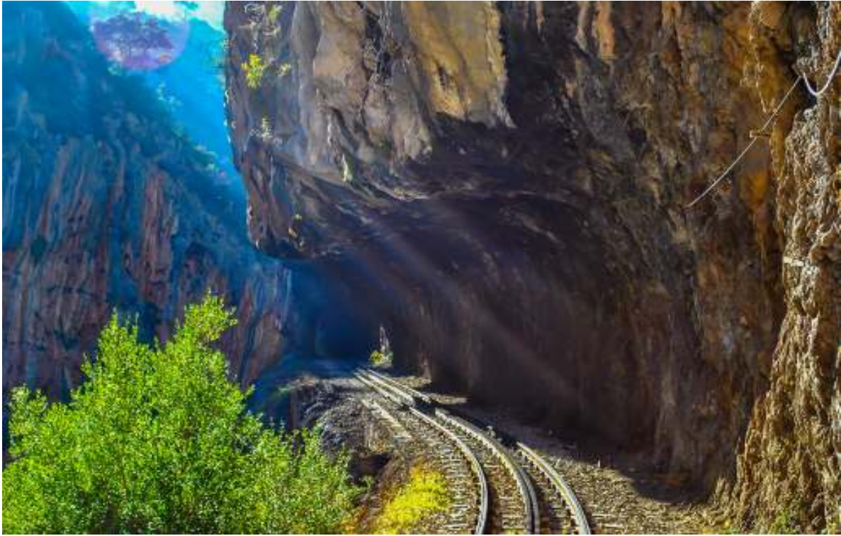
Εικόνα 10: Σιδηροδρομική γραμμή του «οδοντωτού» στο φαράγγι του Βουραϊκού
